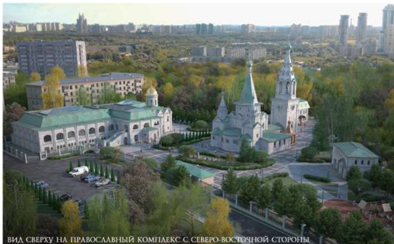
ВИД СВЕРХУ НА ПРАВОСЛАВНЫЙ КОМПЛЕКС С СЕВЕРО-ВОСТОЧНОЙ СТОРОНЫ
